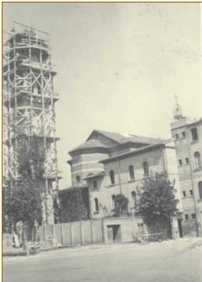
Rimini, 1940. Il campanile della chiesa di Maria Ausiliatrice in costruzione.
