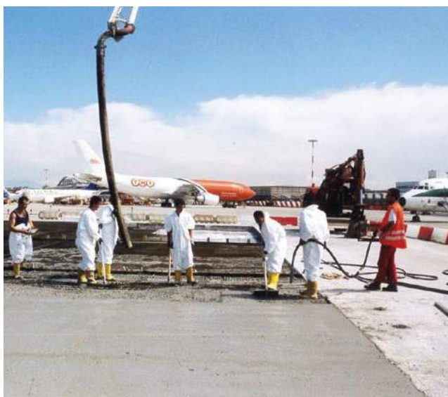
Posa di pavimentazione speciale ad uso aeroportuale.
