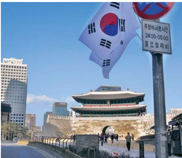
La Grande Porta Sud di Seul oggi, dopo la ricostruzione.
