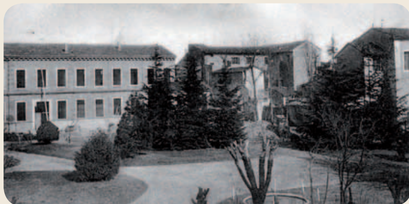
Il Giardino Ferrari prima della costruzione della sede della Cassa di Risparmio.
