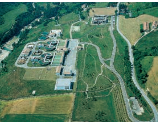
Il potabilizzatore di Capaccio, nei pressi di Santa Sofia (FC).
