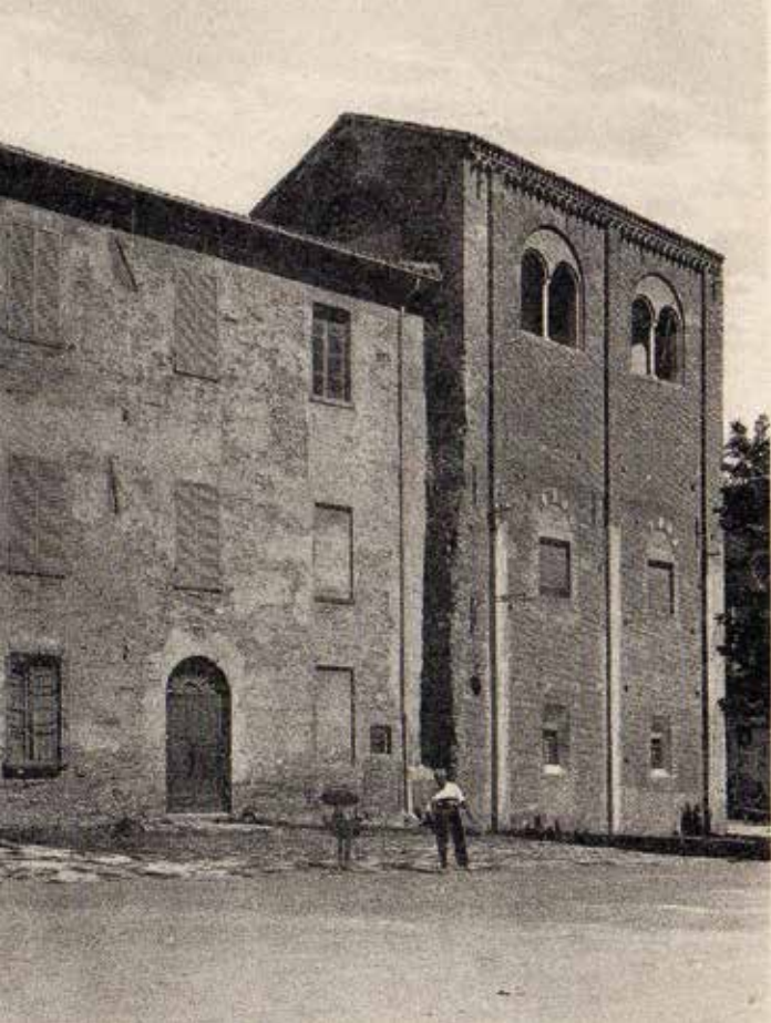
Rimini, primi anni del Novecento. Avanzi del Campanile di S. Colomba, Vecchio Duomo (Arch. F. M.).
